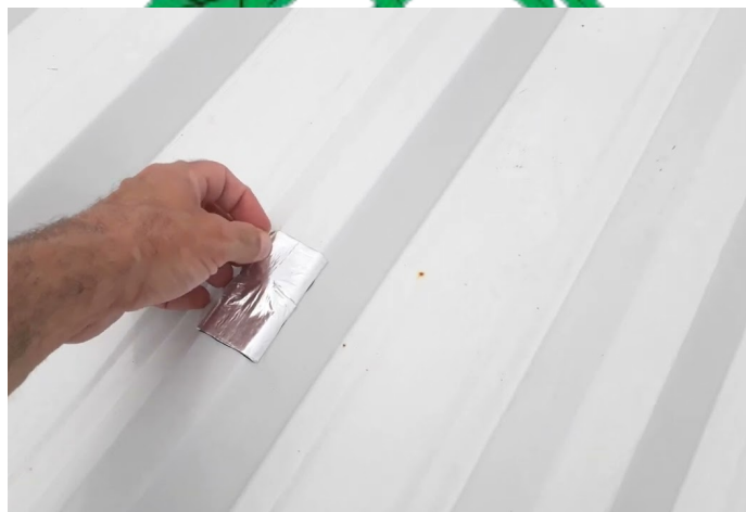
Aplicação de Manta Asfáltica
